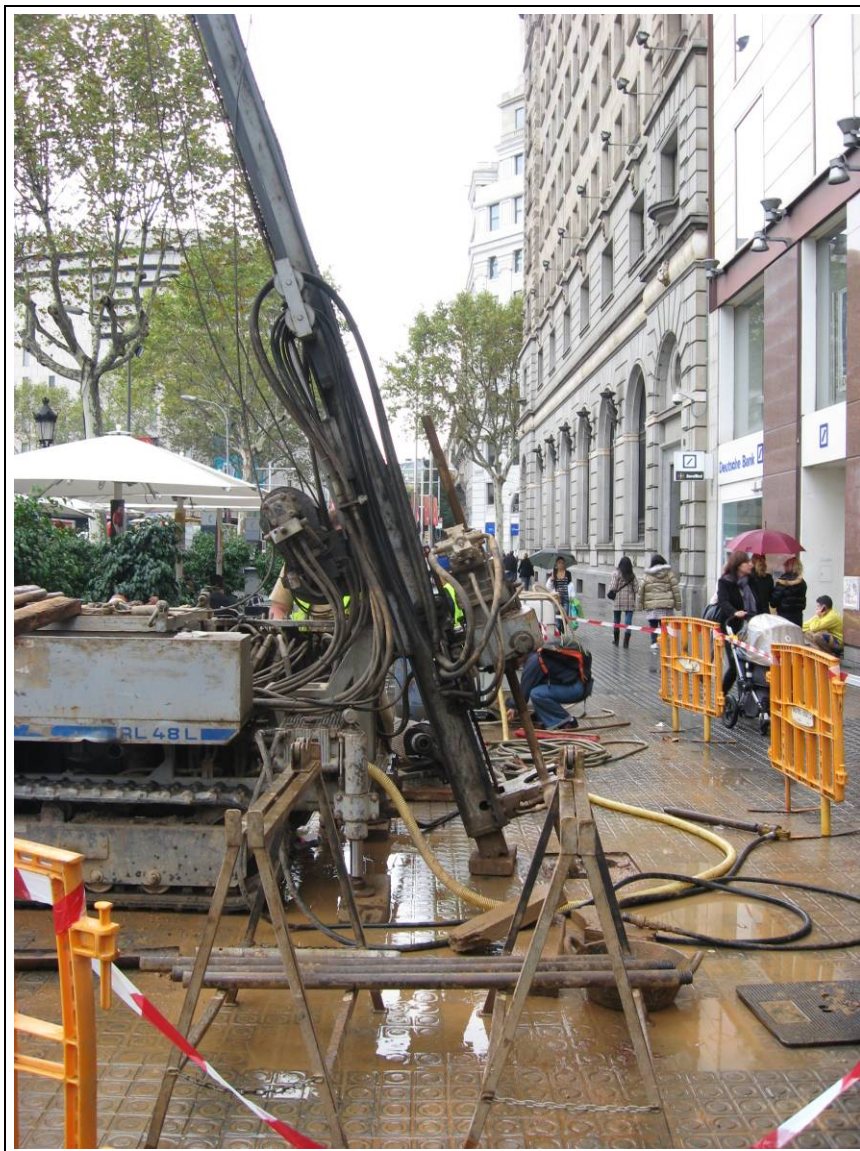
FOTO 3. Vista de la màquina realitzant el sondeig vertical de la segona cala.
