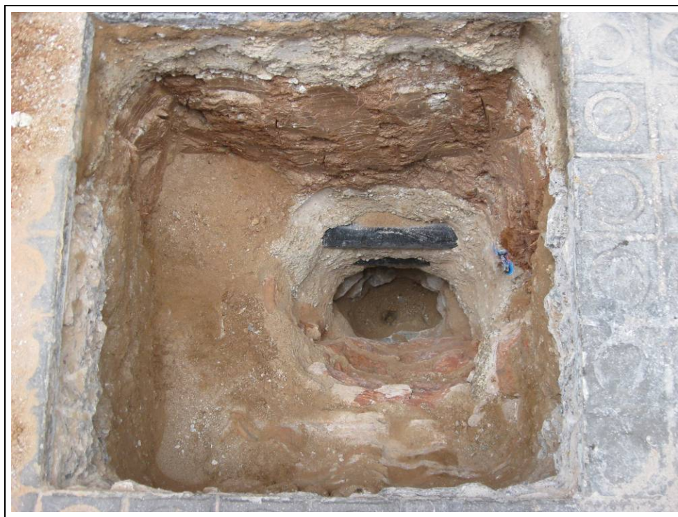
FOTO 1. Cala 1. Foto final i detall del punt en que caldria realitzar el sondeig geotècnic.
