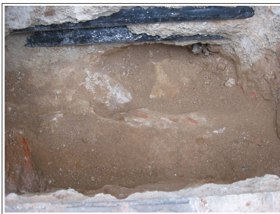
FOTO 2. Cala 2. Foto final i detall de les pedres documentades entre tots dos serveis.
